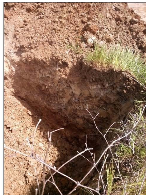
Fotografía.6. Detalle del relleno antrópico localizado en las inmediaciones de la zona de estudio, cara E junto al Colegio Nazaret.
